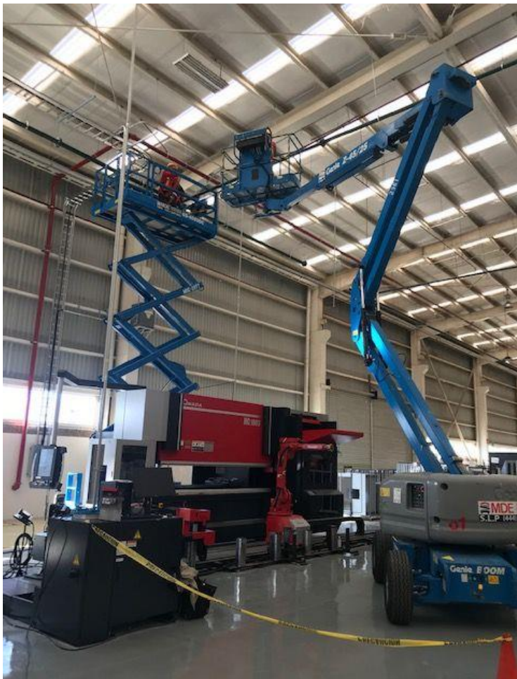
MONTAJE DE TUBERIA DE 3 IN PARA AIRE COMPRIMODO DE 125 PSI
