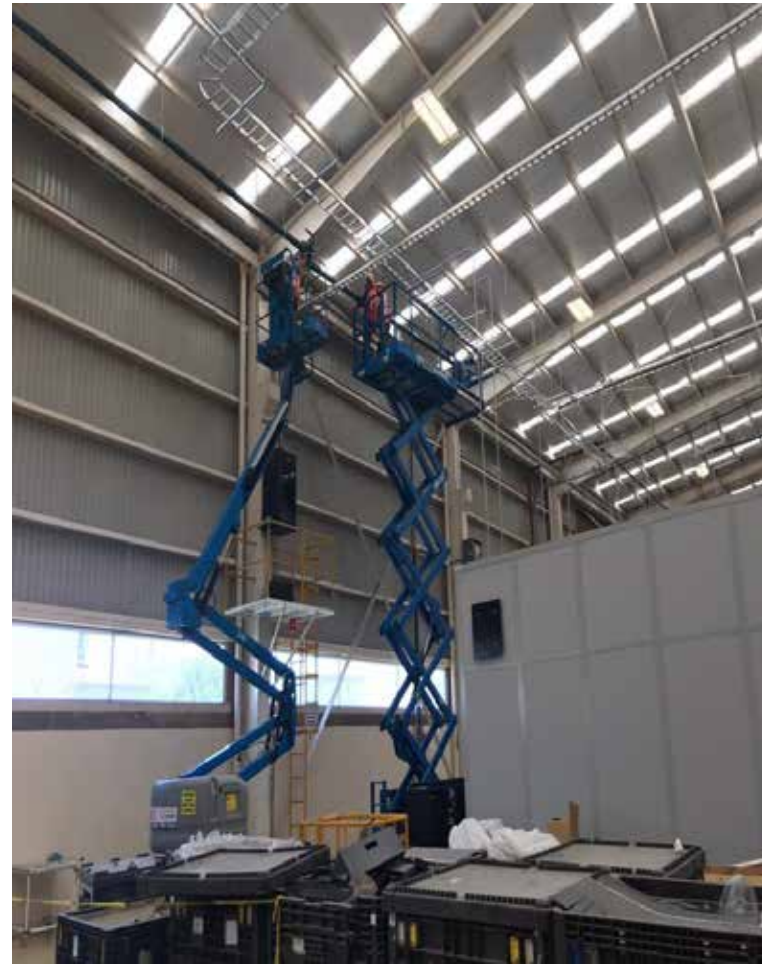
MONTAJE DE TUBERIA DE 3 IN PARA AIRE COMPRIMODO DE 125 PSI
