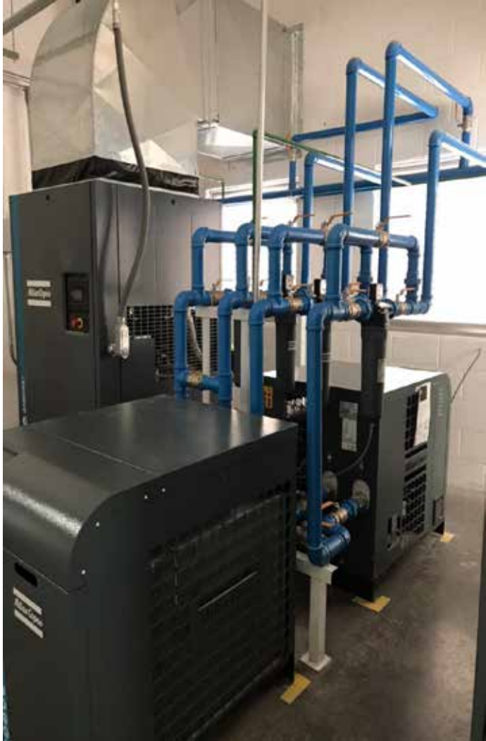
INSTALACION NEUMATICA DE COMPRESORES Y SECADORES MARCA ATLAS COPCO
